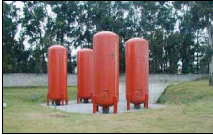
شكل (116) صورة حقيقية لغرفة حماية.
